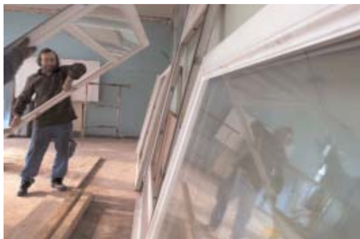
En 2004, les grands travaux bénéficieront à cinq écoles.
